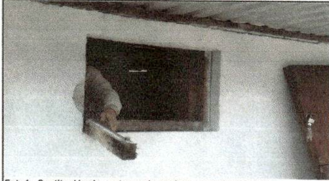
Foto1: Sustitución de ventanas de madera a metal mas vidrios
