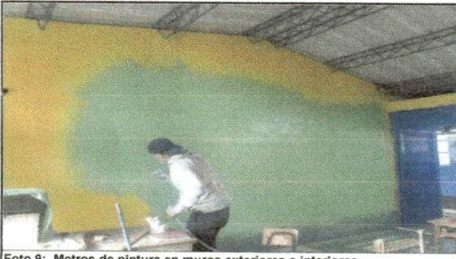
Foto 9: Metros de pintura en muros exteriores e interiores
