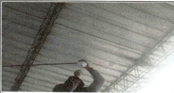
Foto 11: Sustitución de focos ahorradores
