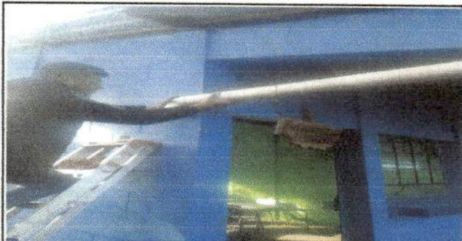
Foto 5: Reparación de bajadas de agua pluvial, tubo pvc
