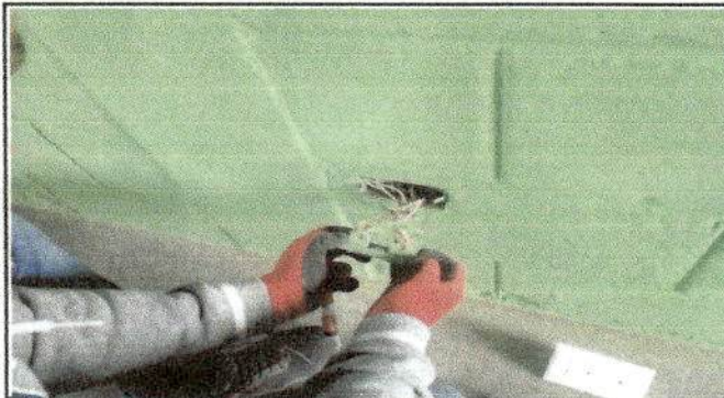
Foto 15: Sustitución de tomacorrientes dobles
