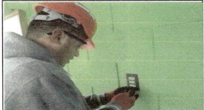
Foto 14: Sustitución de interruptores triples
