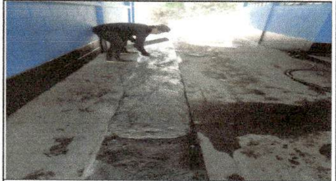
Foto 8: Reparación de cuneta de concreto
