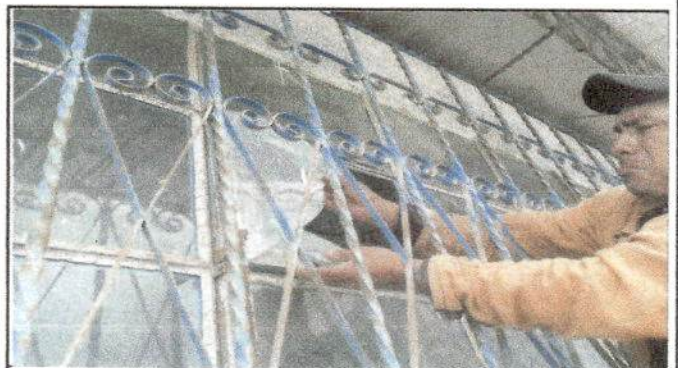
Foto 4: Sustitución de vidrios
