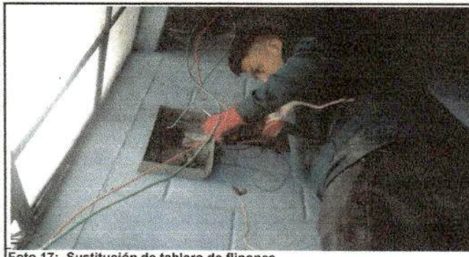
Foto 17: Sustitución de tablero de flipones
