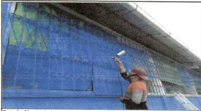
Foto 3: Mantenimiento de balcones
