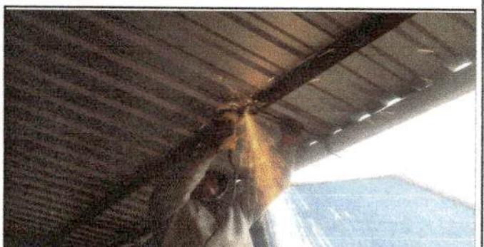
Foto 6: Sustitución de pescante de metal para canal
