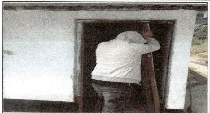
Foto 2: Sustitución de puerta de madera a metal
