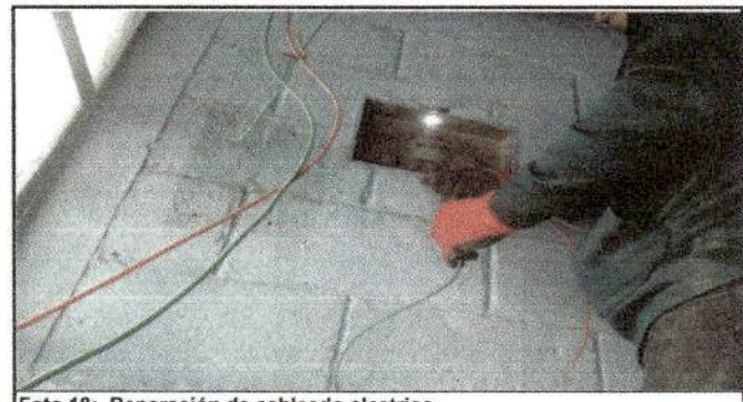
Foto 18: Reparación de cableado eléctrico
