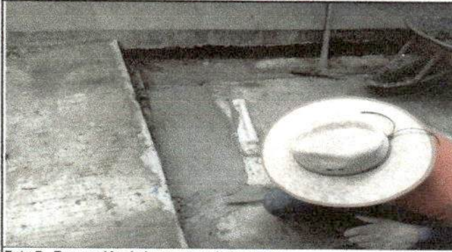
Foto 7: Reparación de banquetas de concreto
