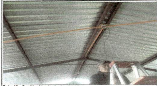
Foto 19: Sustitución de ducto electrico
